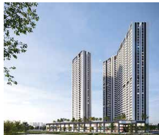
Dự án: The Estuary Đà Nẵng
